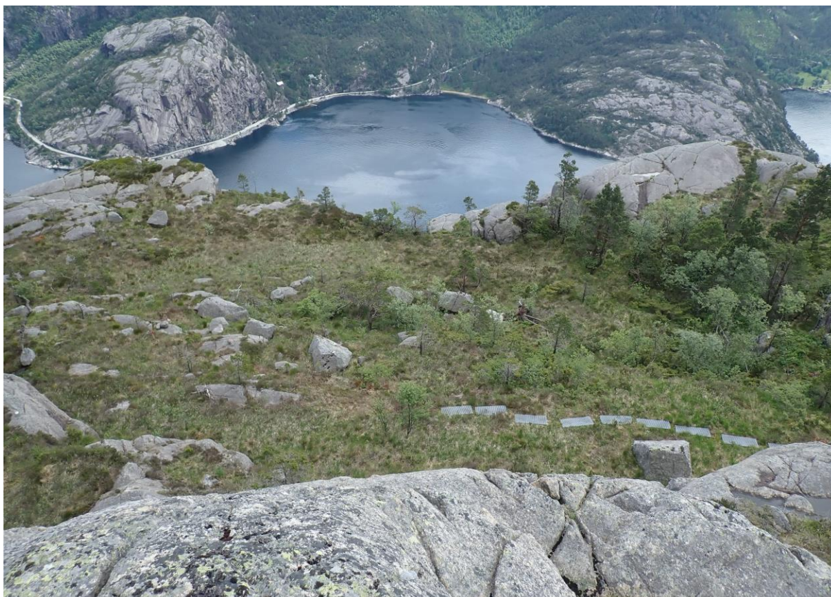
Figur 2.7. I de høyereliggende områdene i midtre delen er stien lagt på «avsatser». Her hellelagt over fuktige partier. Foto: Toralf Tysse ©.
